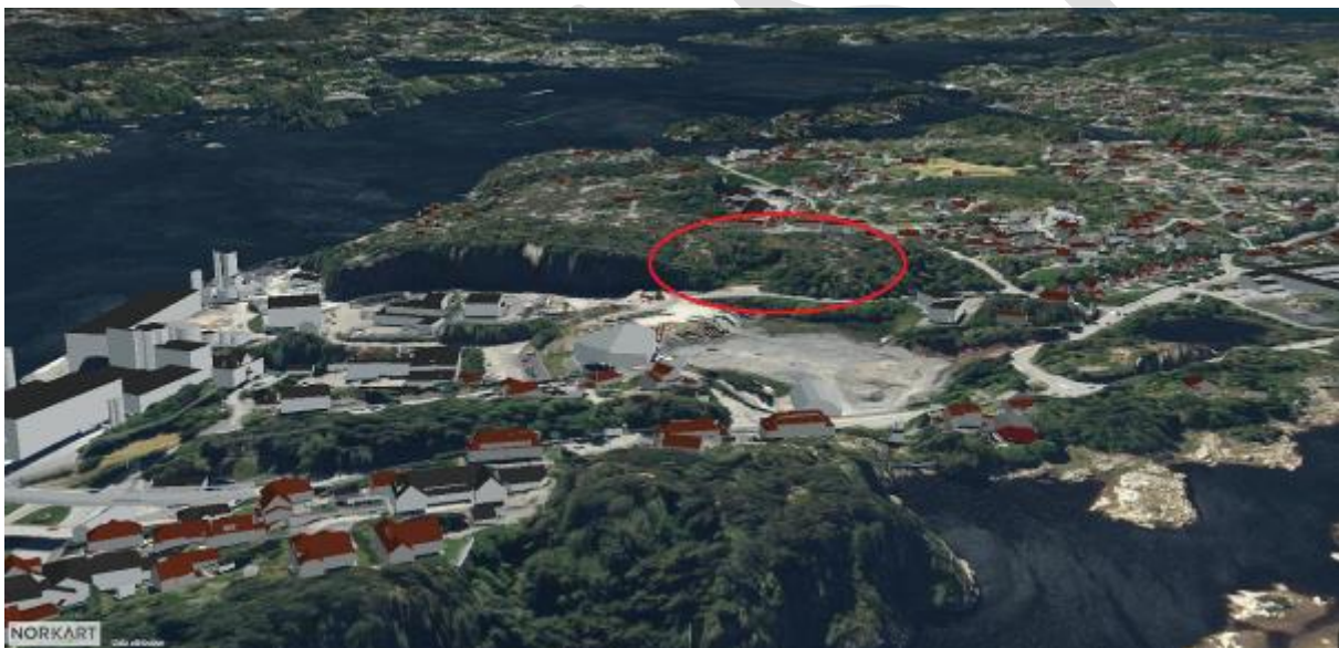
Planområde set frå nord. Til venstre er det ei stor skjering. Nytt Sotrasamband går inn i denne skjeringa.
