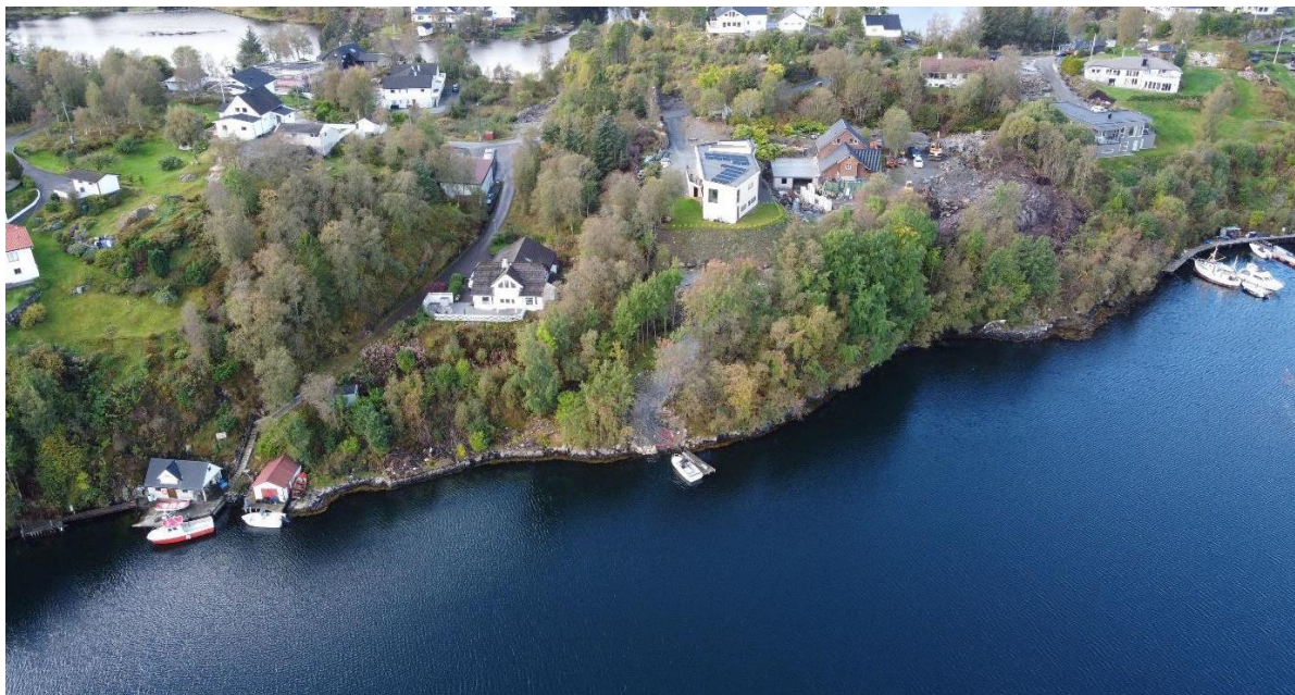
Dagens situasjon sett frå aust
